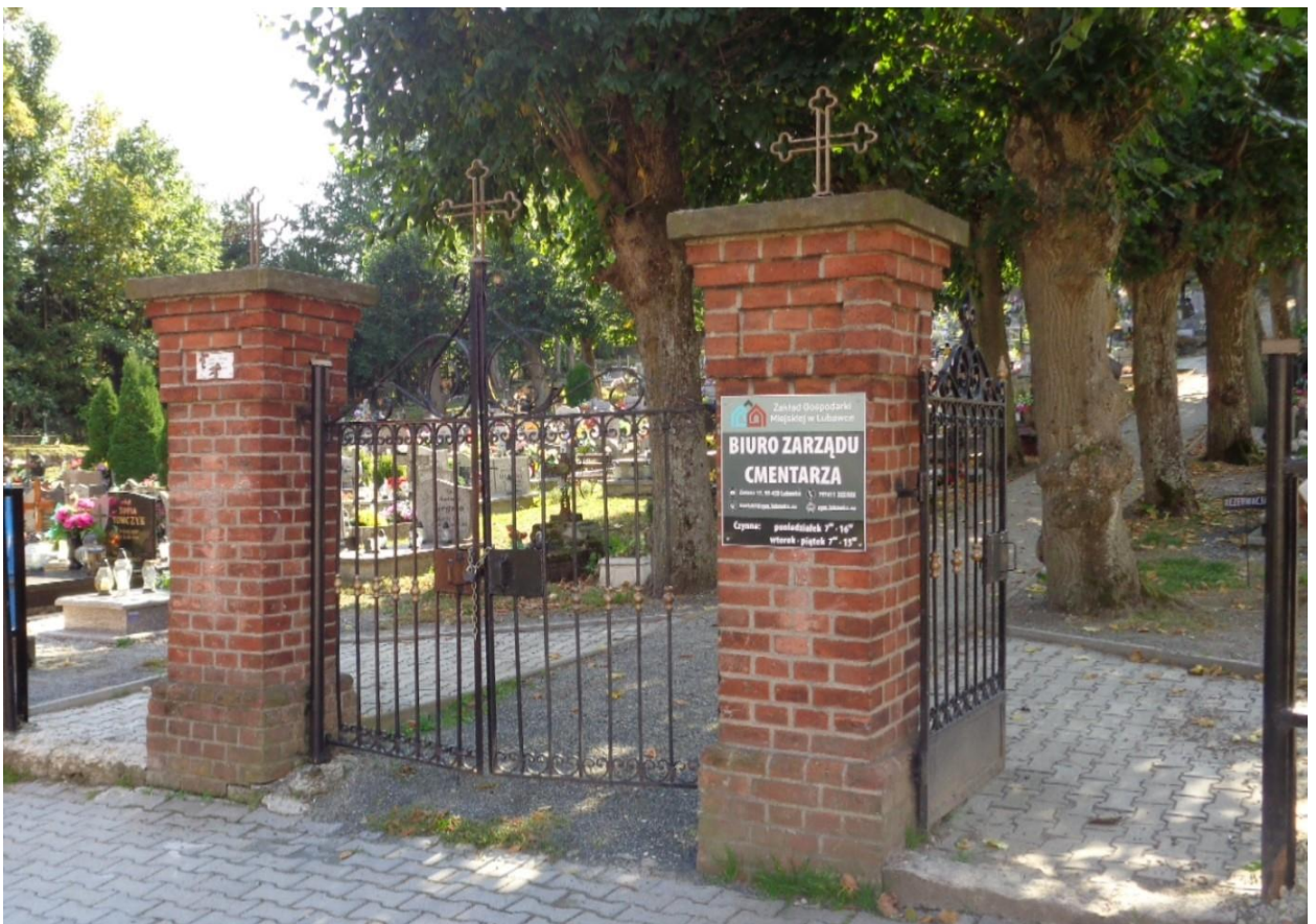
Brama cmentarna po remoncie
