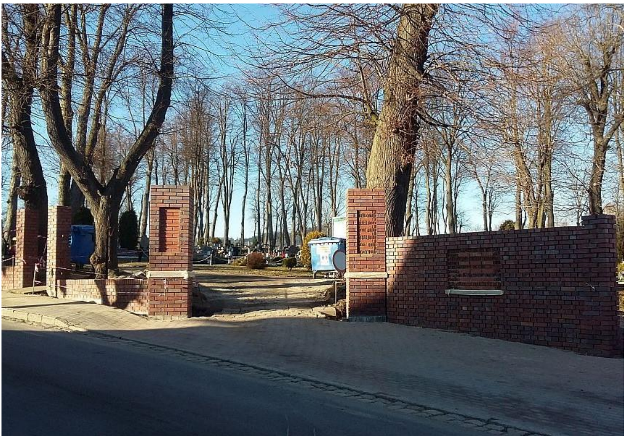
Brama cmentarna w toku przebudowy
