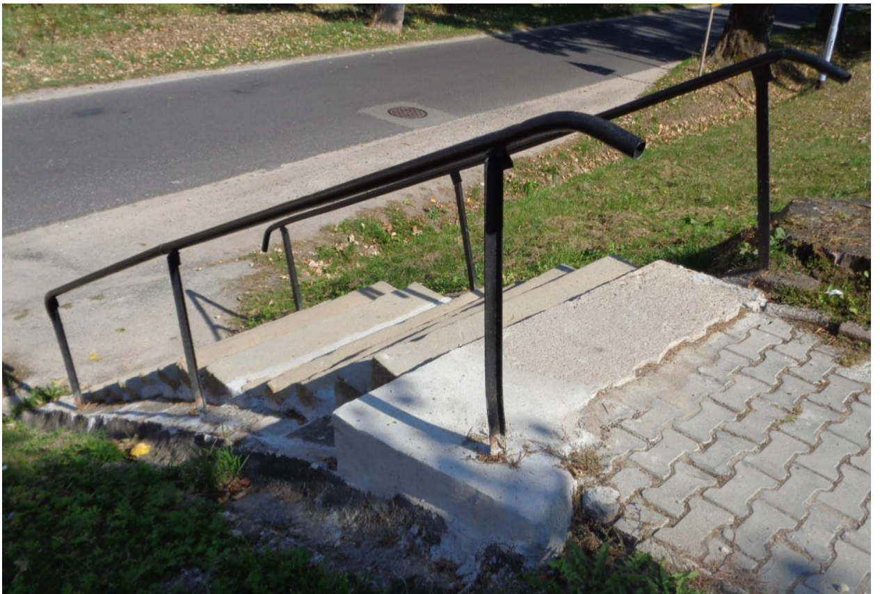
Schody po remoncie
