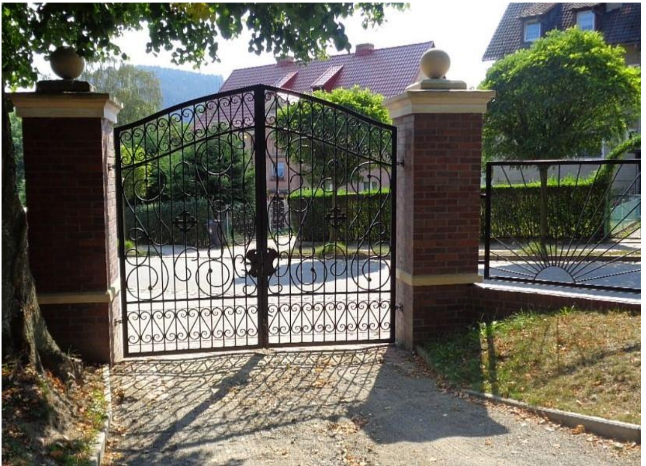
Brama cmentarna po zakończeniu przebudowy
